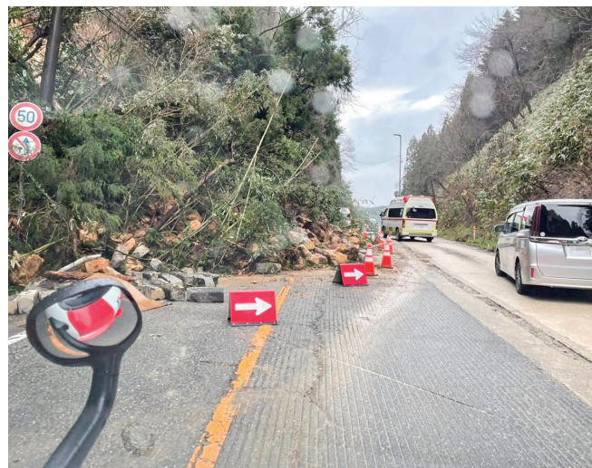
▲土砂崩れや陥没、地割れによる厳しい道路状況
