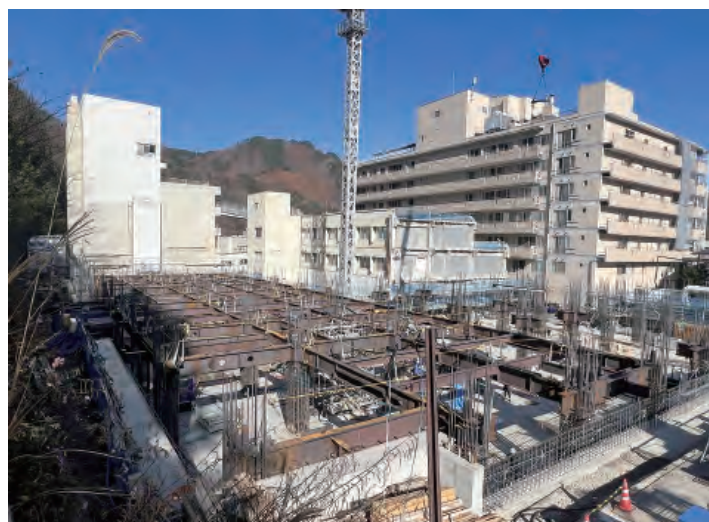
▲1階部分の工事の様子。奥に見えるのは南病棟
