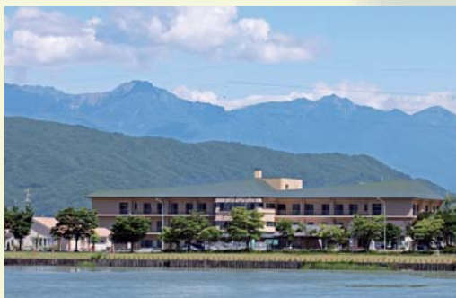
▲老人保健施設 みづうみ 諏訪事業部
